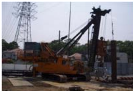
上杭吊り込み
