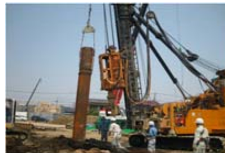
上杭吊り込み
