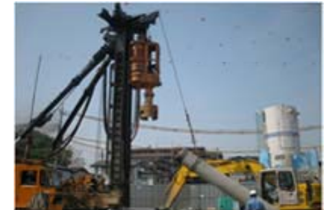
杭くわえ込み
