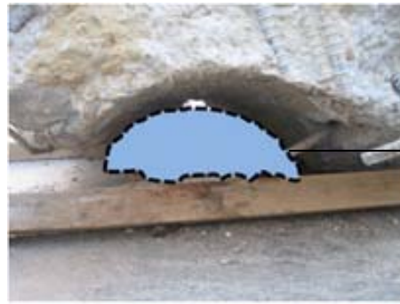
場所打杭を掘削
