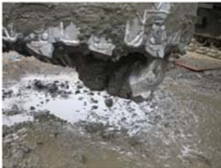
ケーシングが逆回転をし、中の スクリーヘッドが正回転をし、 石やコンクリートを破碎する
