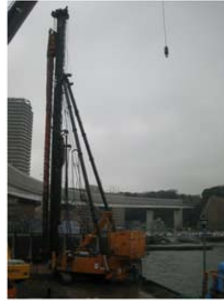
狭隘地での施工
