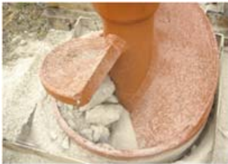
鉄筋コンクリートを掘削
