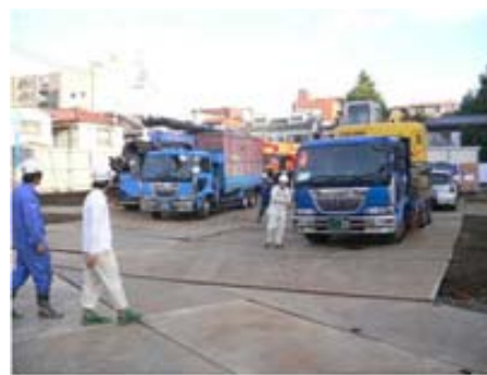
杭打機材搬入完了
