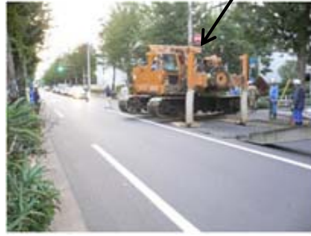
アウトリガを使用して方向転換 (ペガサス)
