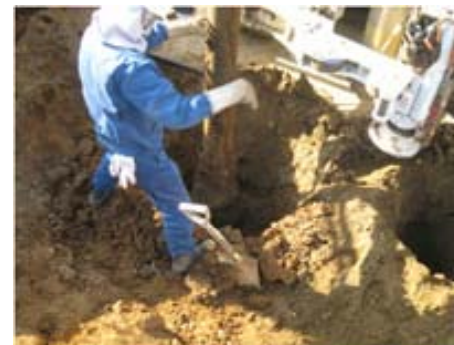
山砂埋め戻し状況
