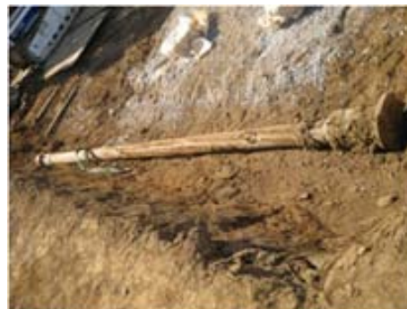
杭抜き穴埋め戻し治具
