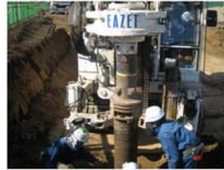
杭の抜きはじめ
