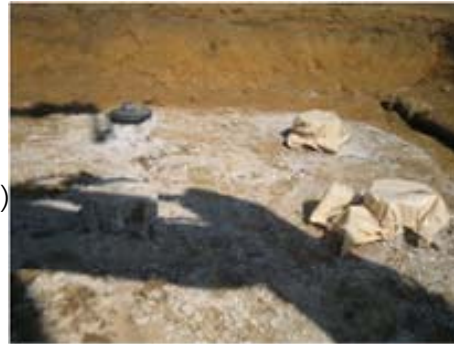
杭を抜く直前の状況
